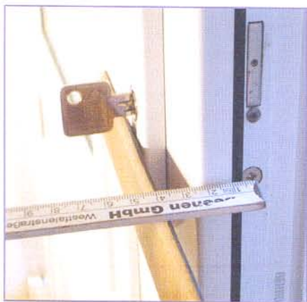
Bild 1: Die Maße des erforderlichen Schließzylinders sind einfach zu ermitteln.
